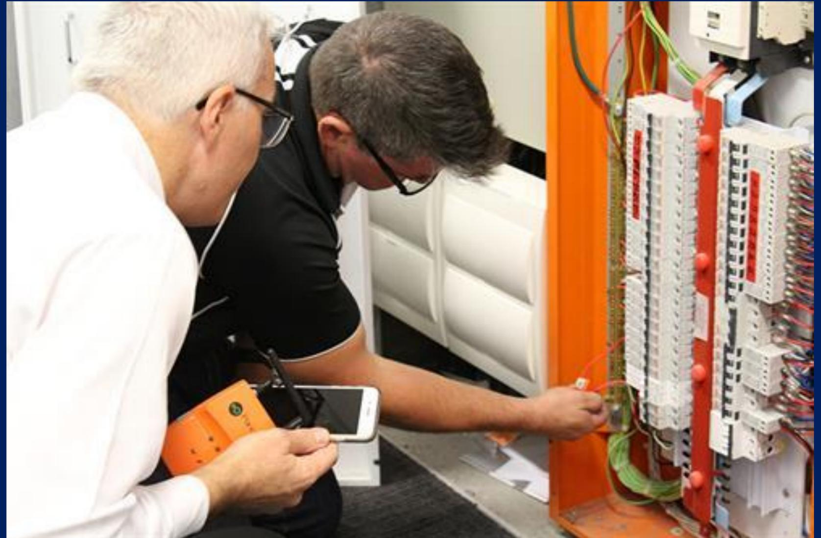
I sensori non invasivi, facili e veloci da montare, con chiusura a scatto attorno al cablaggio del dispositivo. Ogni singolo sensore inizierà a monitorare il consumo di energia del dispositivo, dell'apparecchiatura o dell'intero processo..
